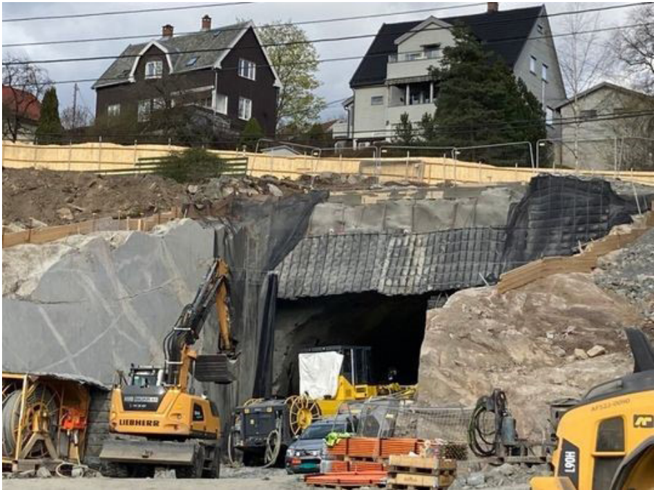
Østsjøbanens ombygging nær Bryn er i full gang rundt tunellinnslaget ved Bryn i juni 2022. Fotograf Frode C. Jakobsen.
